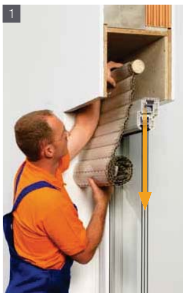
1 Alten Rollladen aus Kasten entfernen!
