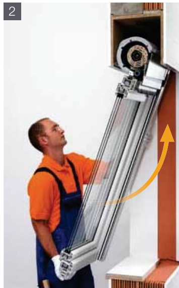
2 Fenster mit TERMO einsetzen!
