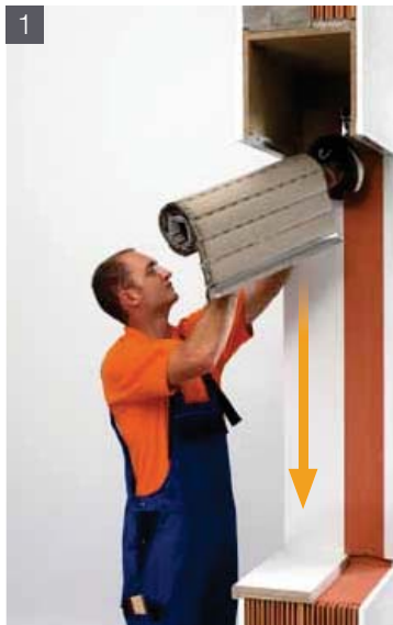
1 Alten Rollläden aus Kasten entfernen!
